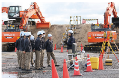
新入社員研修 (ICT施工)
