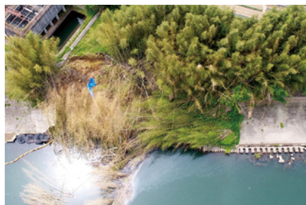
護岸災害復旧工事（那珂川） 着工前
